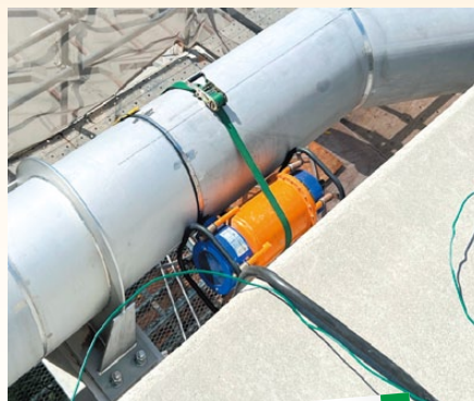
この機械を使って管の内部を 検査しています!
