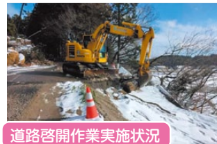
道路啓開作業実施状況
