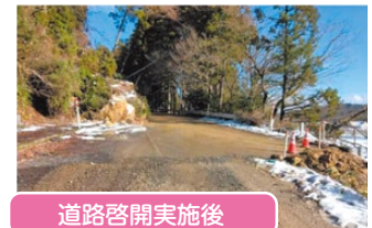
道路啓開実施後
