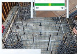
ラーメン高架橋
